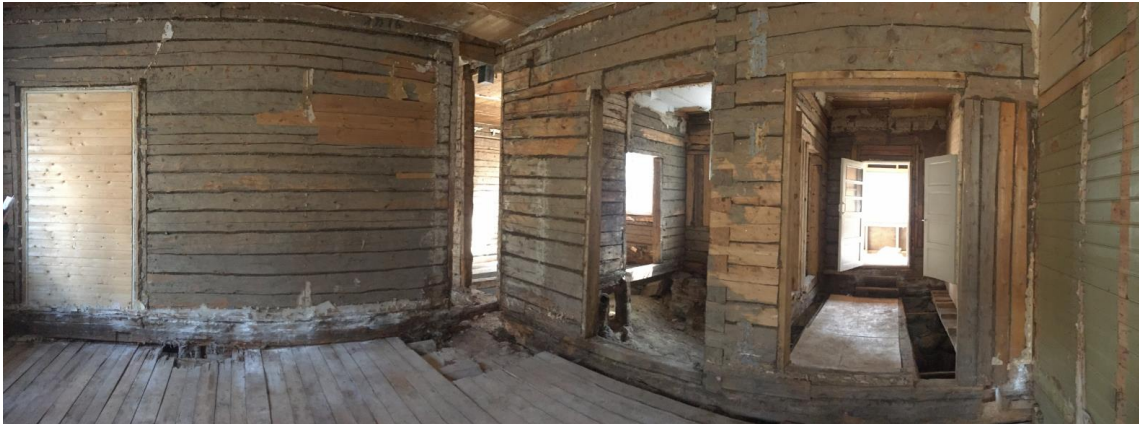
Kuva 6. Valokuva kohteen sisältä.
