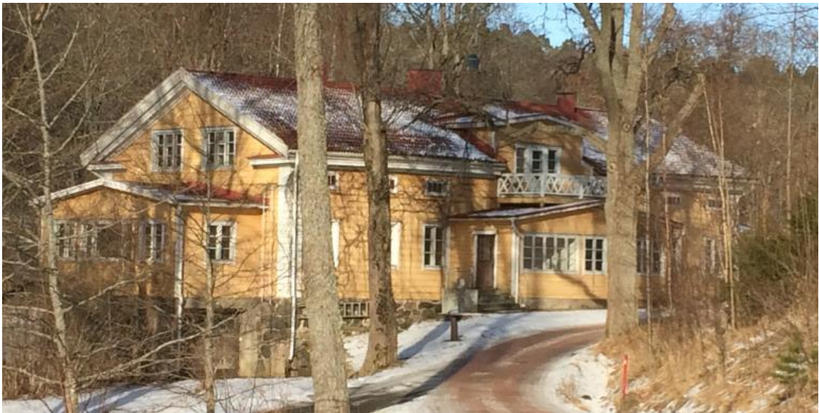
Kuva 1. Parkvillan etelästä päin kuvattuna.
